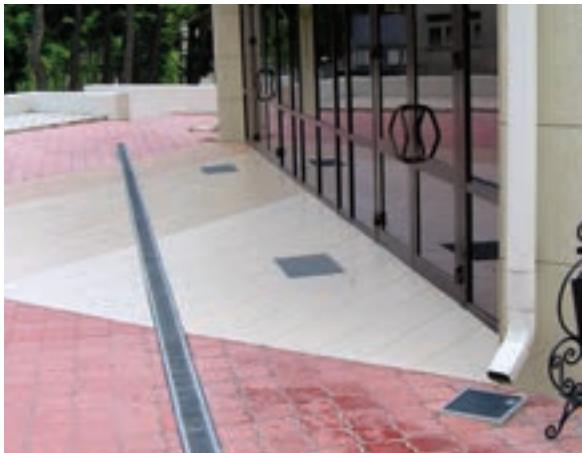
Дождеприемники — элементы точечного водоотвода. Их применение в инженерных сетях — традиционный метод сбора талых и дождевых вод. Локальные дождеприемники точечно расположены на территории объекта, что позволяет собрать воду в местах большого скопления.
